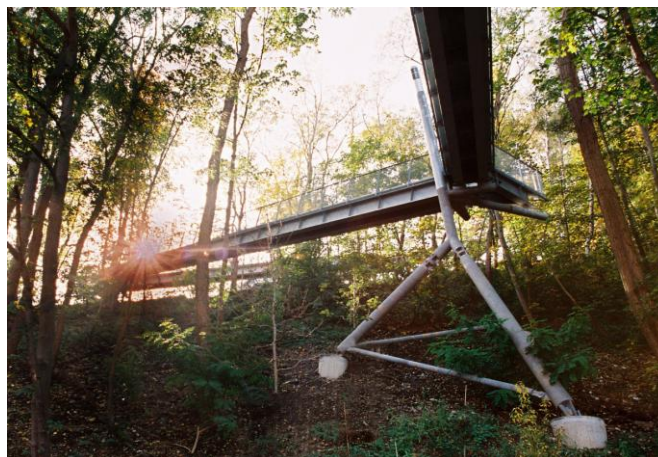
Plovoucí chodník na tetrapodových podporách
