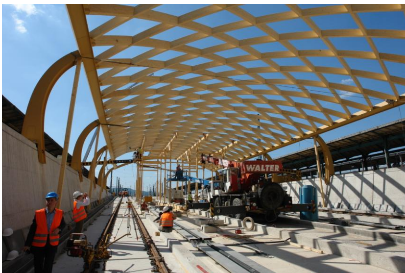
Stavební fáze výstavby zastávky Regio-Tram v městě Kassel
